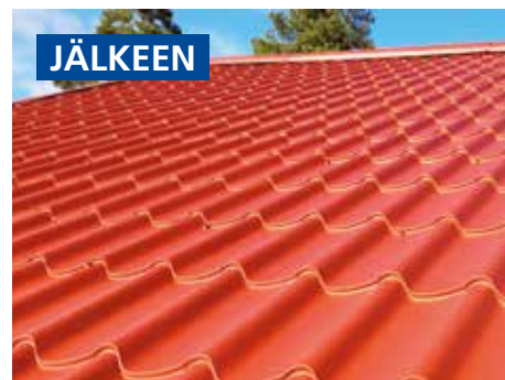
Ehjä peltikatto vuodelta 1995. Uusi pinta 2020. Seuraava huolto 2060.
