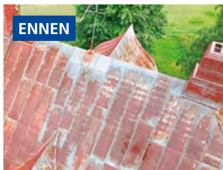
Peltikatto vuodelta 1926. Huoltomaalaus tehty 2020. Suositus huoltomaalaukselle 2050.
