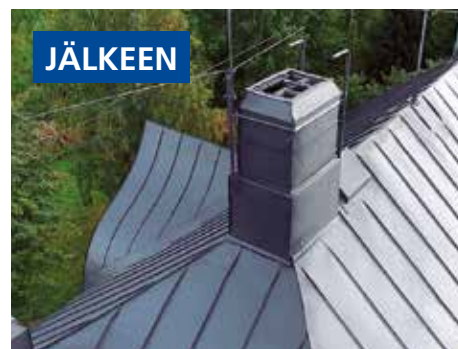
Peltikatto vuodelta 1926. Huoltomaalaus tehty 2020. Suositus huoltomaalaukselle 2050.
